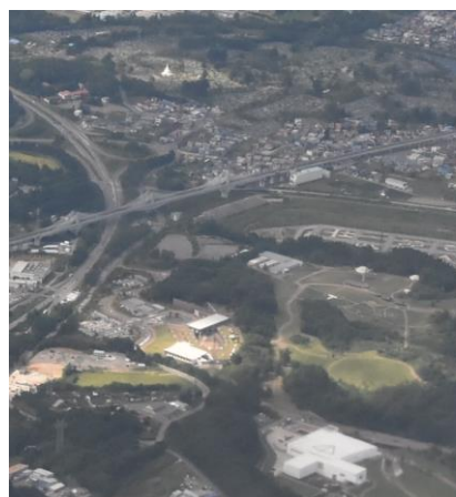
三内丸山遺跡（下部全体）と三内丸山架道橋 = 筆者撮影
